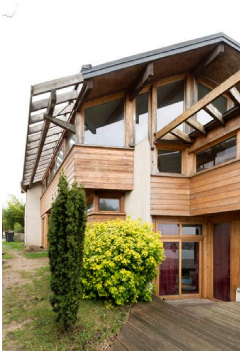
Détail de la façade postérieure.
