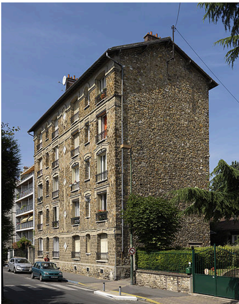
Vue en perspective de l'immeuble depuis la rue
