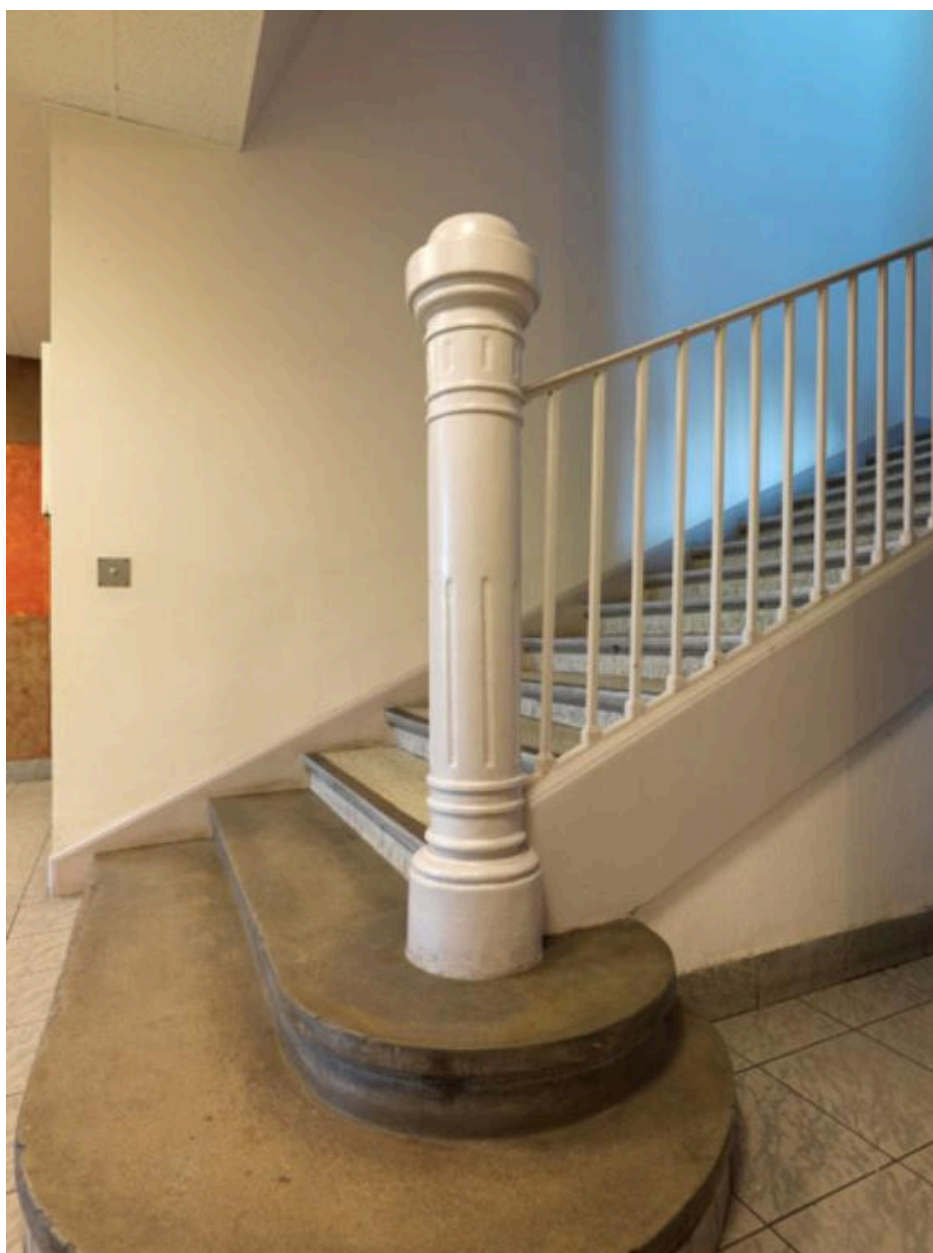
Vue de l'escalier intérieur.
