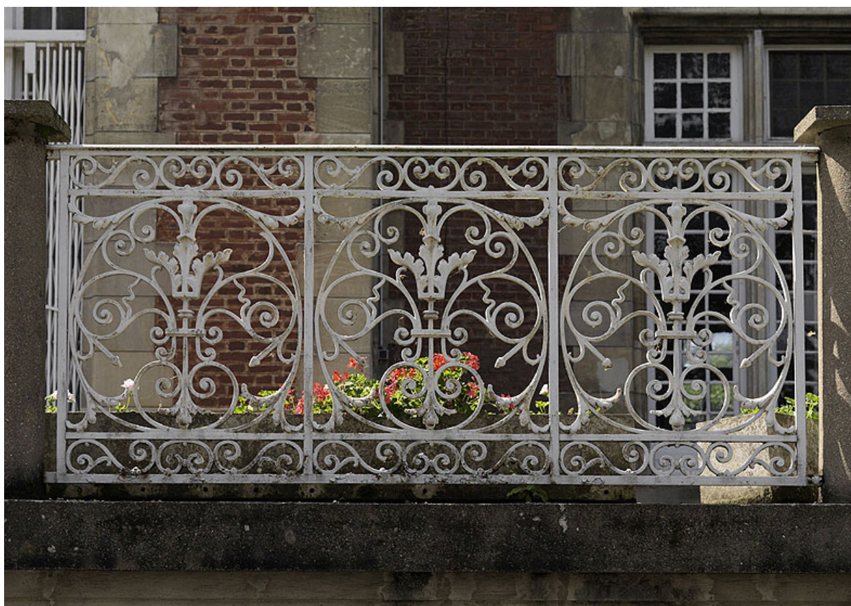
Détail du garde-corps de fonte ornant la grande terrasse donnant sur le lac.
