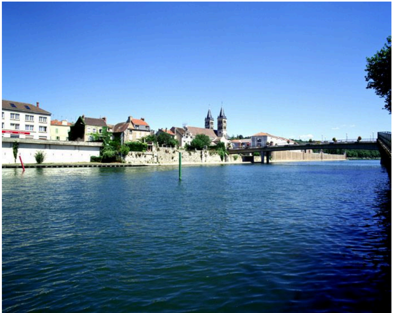
Partie orientale de l'île Saint-Etienne, vue depuis la rive sud.
