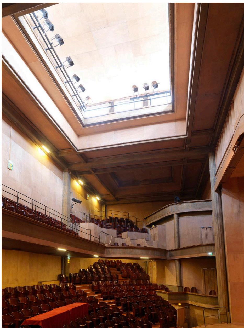
Plafond de la salle
