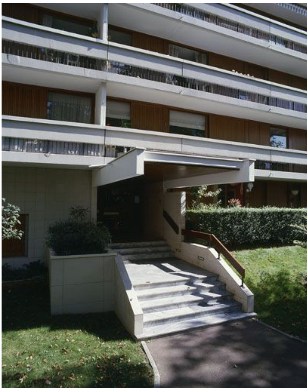
Détail d'une porte d'entrée (immeuble R+8, à l'arrière de la piscine).
