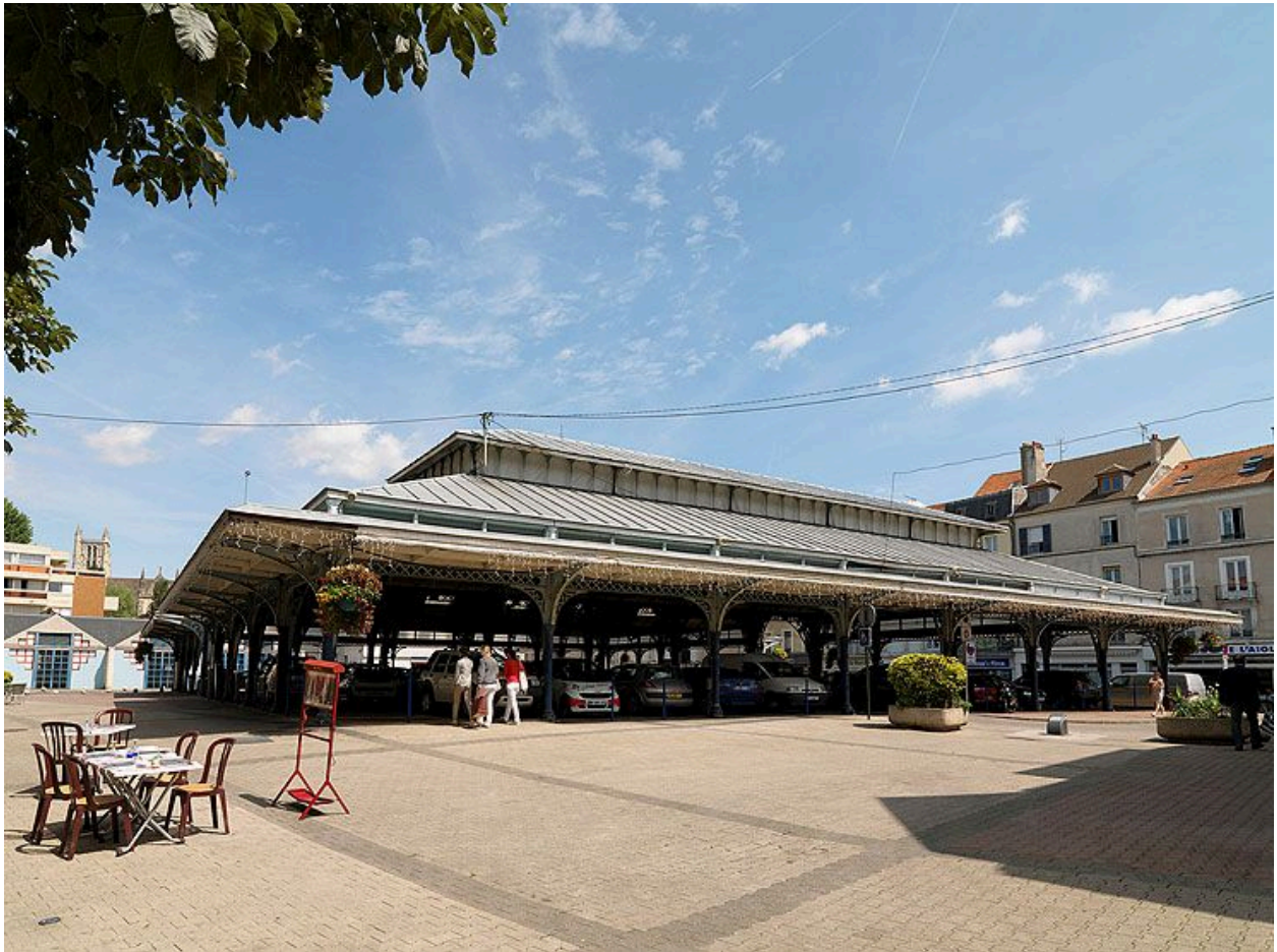
Vue extérieure d'ensemble, depuis le sud-ouest.
