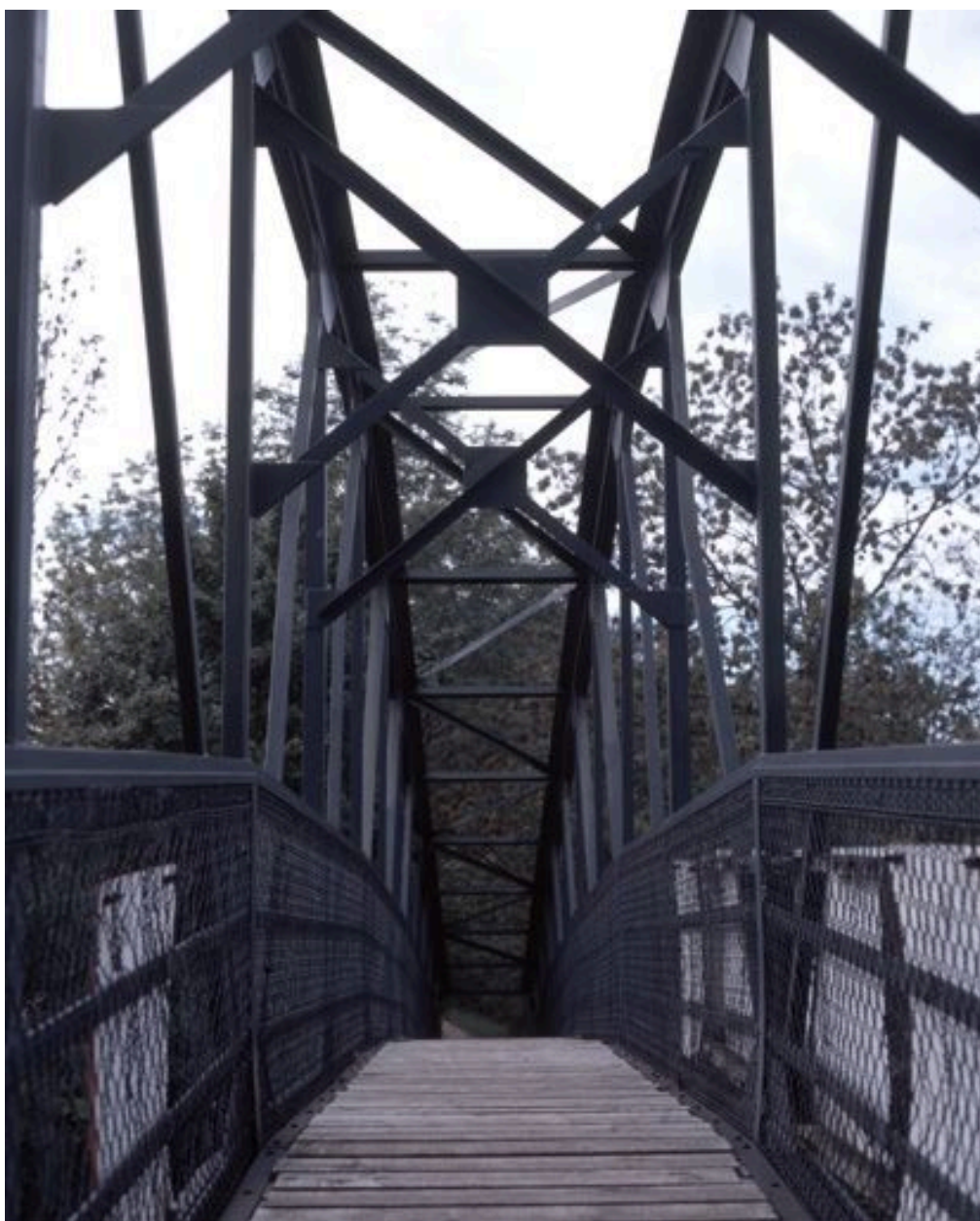
Détail de la passerelle métallique du port de plaisance.
