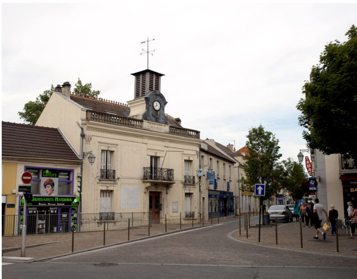
Ancienne mairie-école, 167 rue Pierre Brossolette, antécadastre.
