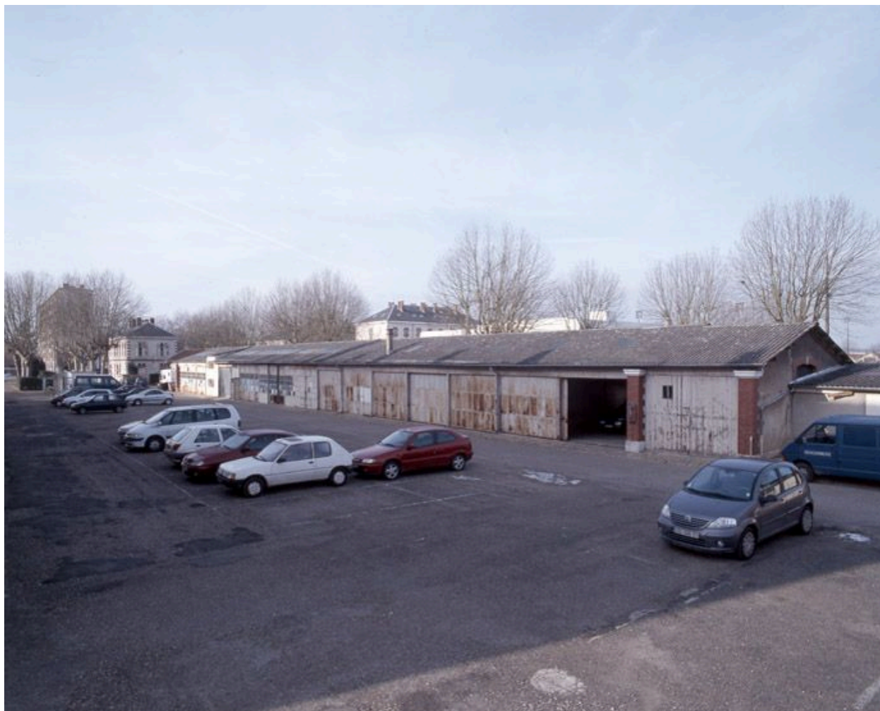
La caserne Augereau : hangars bordant la rue Emile Leclerc.
