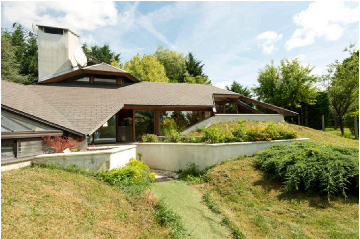
Détail de la façade principale, côté droit.
