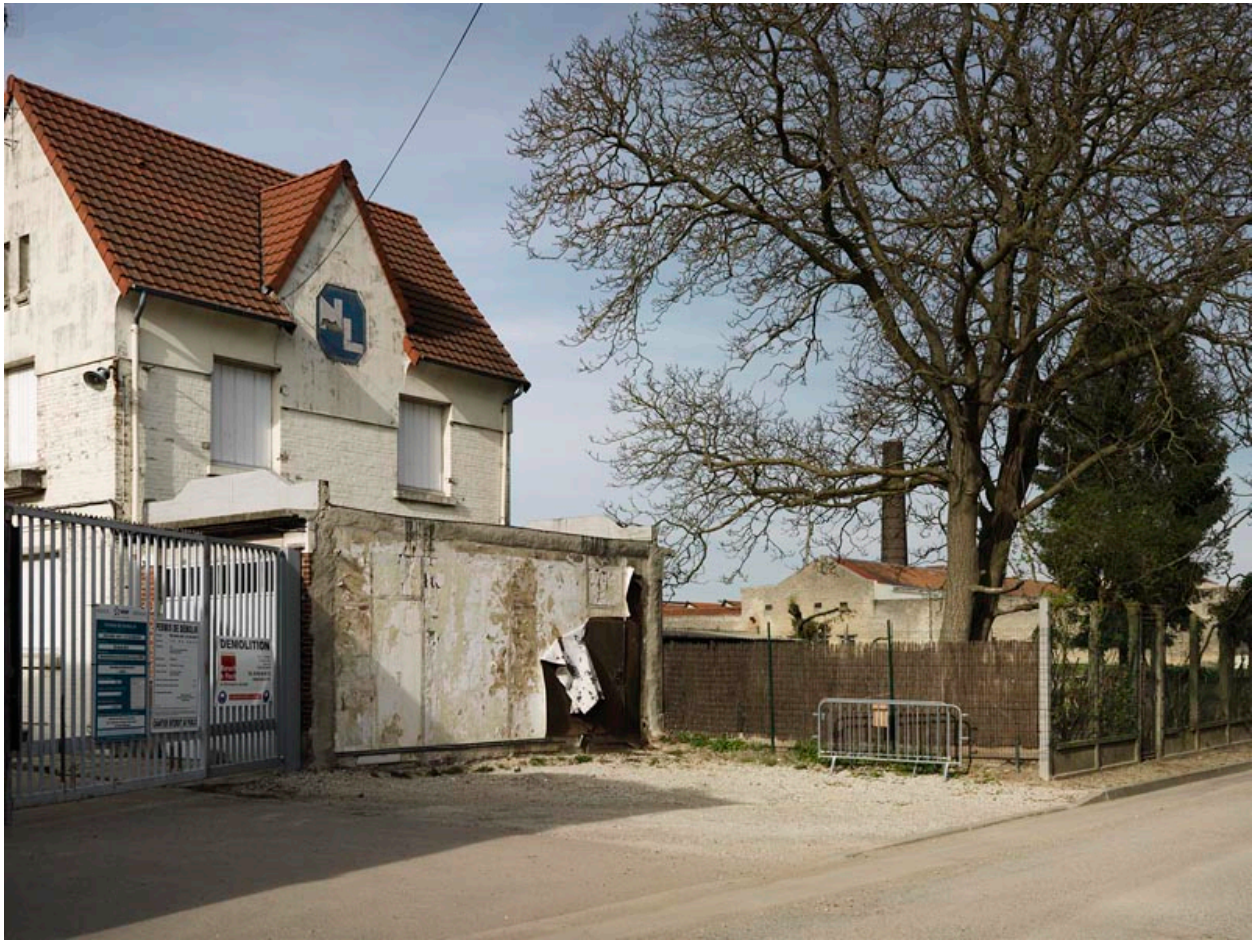
Persan. Autour de l'usine Hutchinson. Ancien transformateur électrique Nord Lumière.
