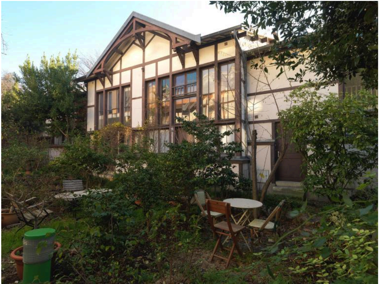
Vue de la façade d'un atelier dans la première cour
