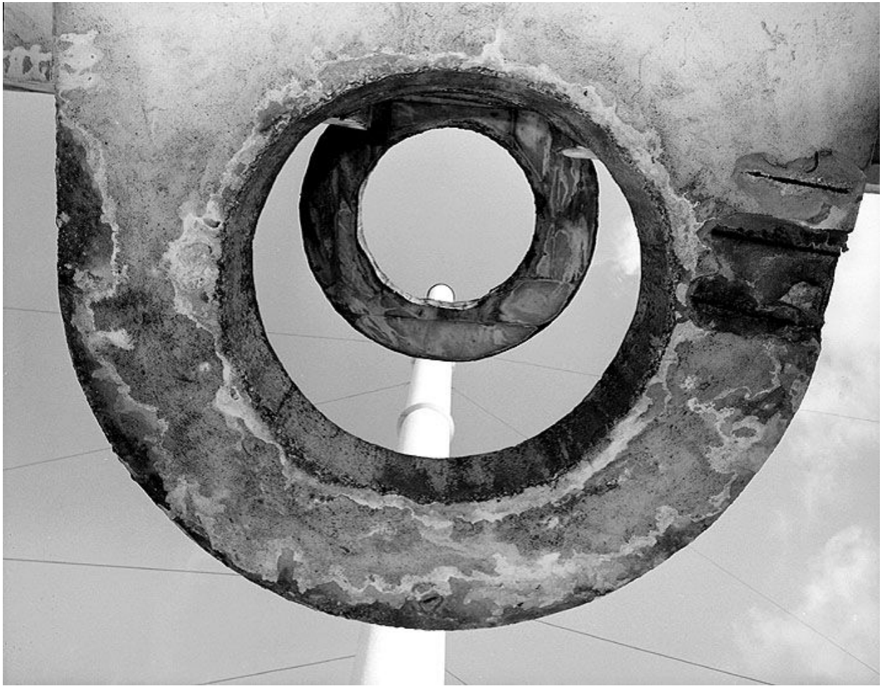
Détail de la façade nord du bâtiment du cuvage. Photographie avant destruction, 1989. (Ministère de la culture, Inventaire général. 89SG720X)
