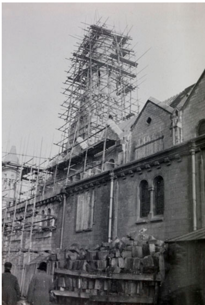
Vue de la construction de l'agrandissement en 1930. (AM Enghien-les-Bains, M48)
