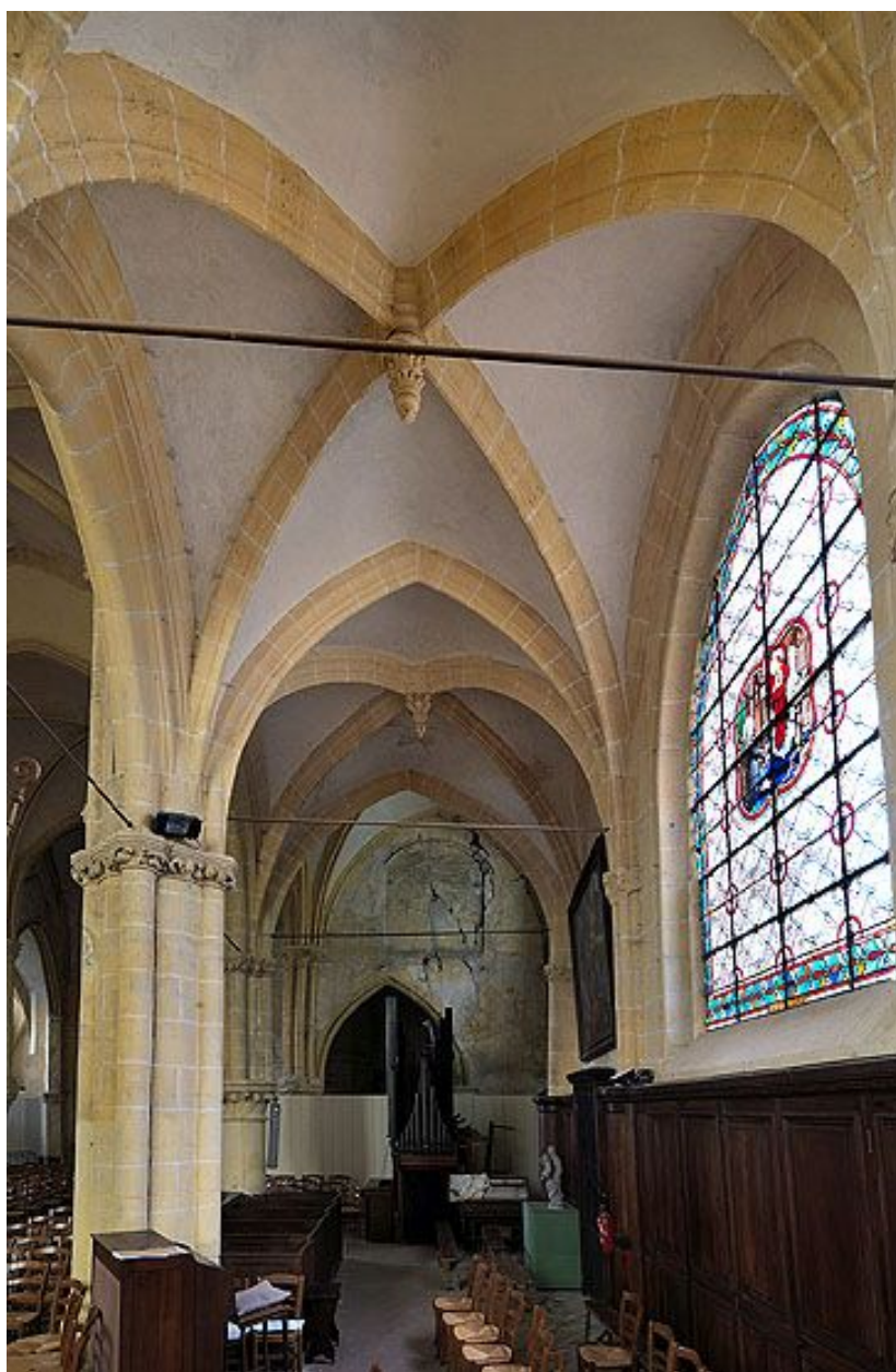
Vue intérieure du collatéral nord, depuis l'est.
