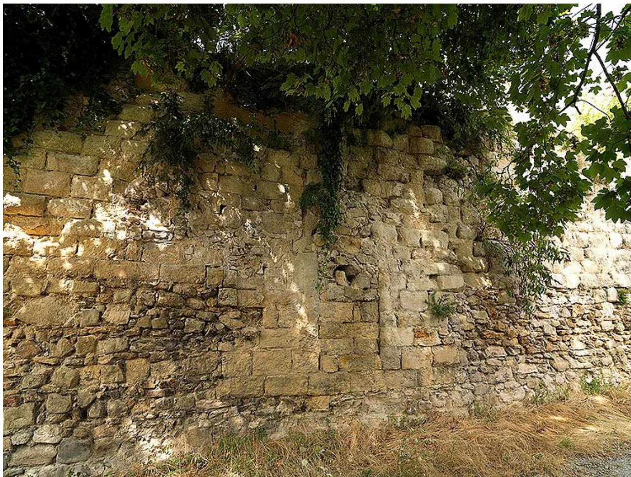
Pan de courtine avec trace de poterne, vestige des fortifications du Marché le long du canal de Cornillon (côté ouest).
