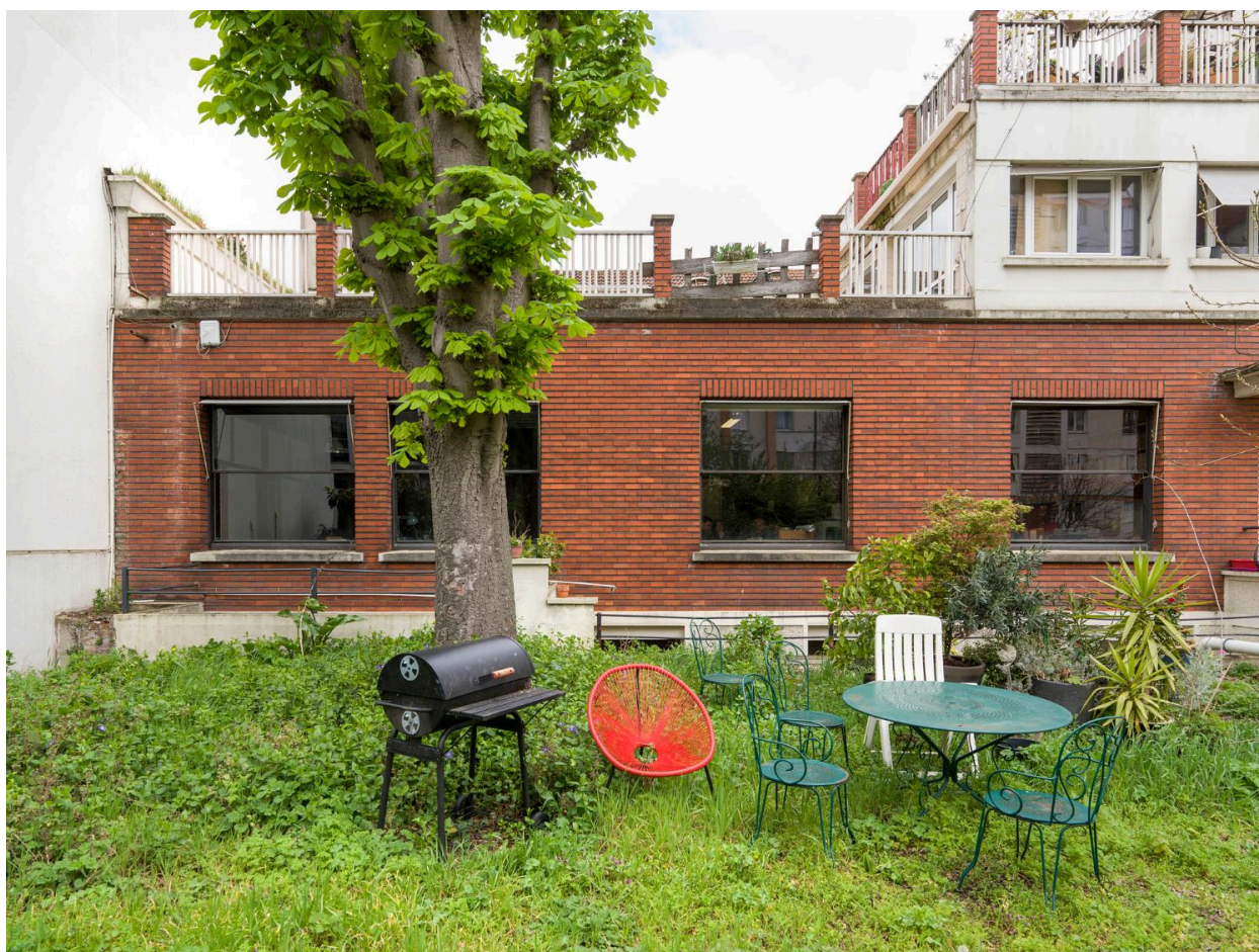
Façade des bureaux livrés fin 1959.
