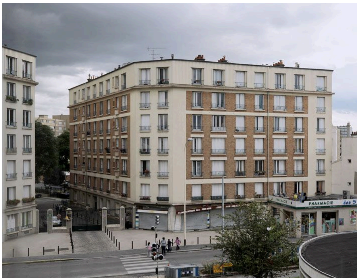
Cité du Foyer des Invalides et des Anciens Combattants. Vue d'un bâtiment de la cité du FIAC. E. Thomas et Pavot (architectes), 1931.
