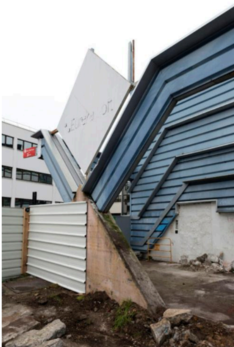
Détail de la façade latérale.
