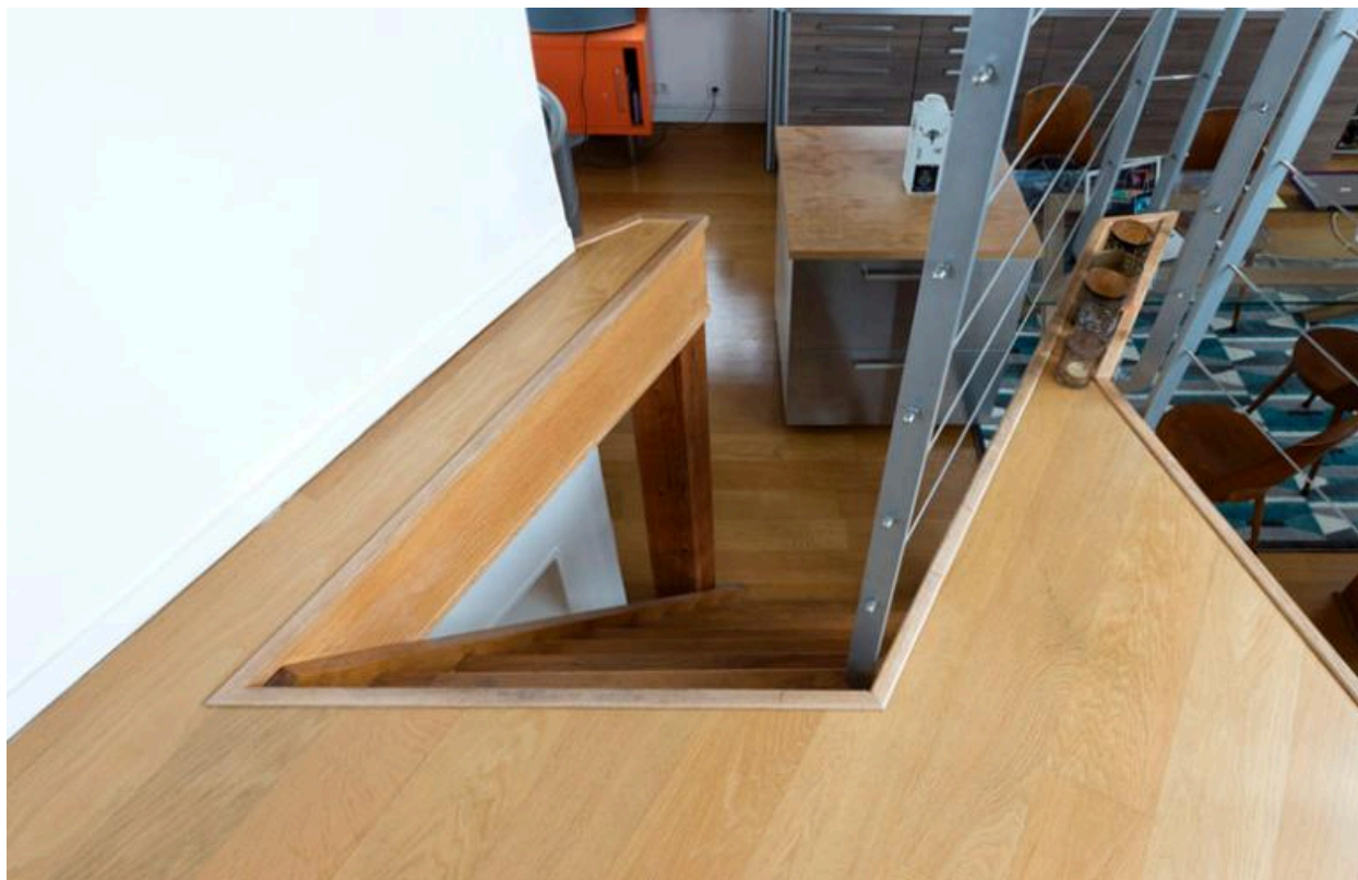
Vue de la cage de l'escalier prise depuis le palier supérieur.
