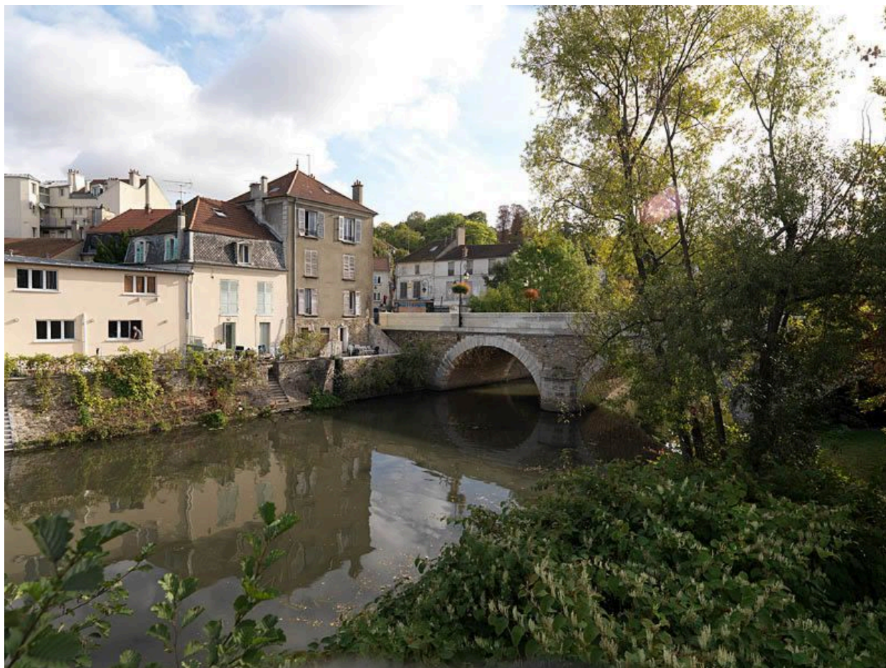
Villeneuve-Saint-Georges, pont sur l'Yerres.
