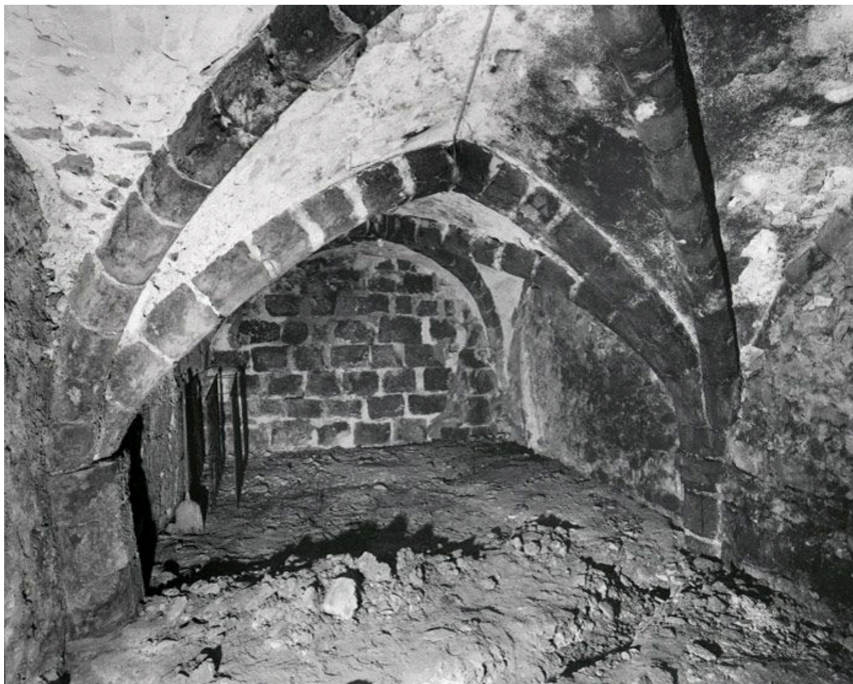
La cave médiévale : vue depuis l'angle sud-est.
