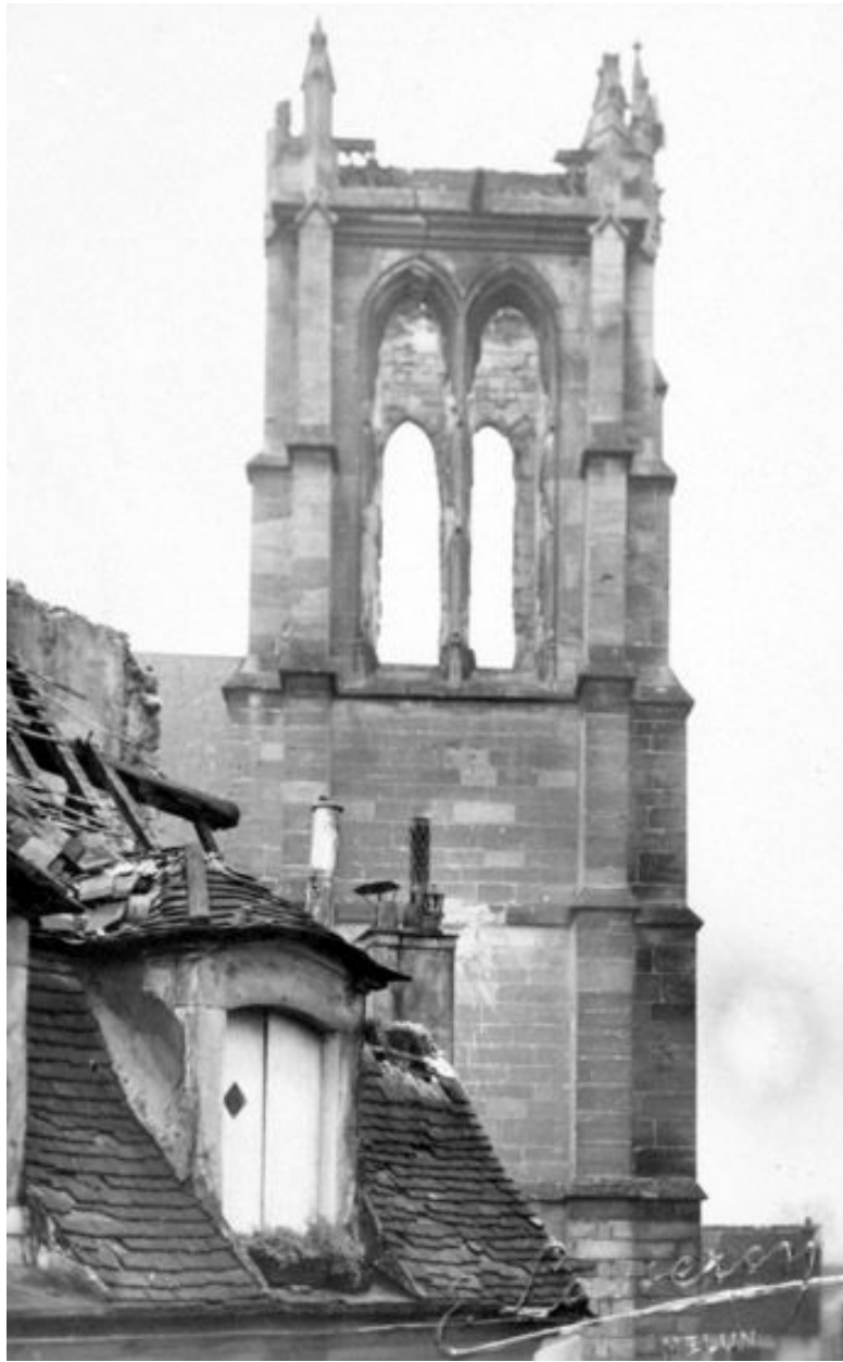
Le clocher après son bombardement. Photographie, vers 1944. (AM Melun. 3 Fi 19)
