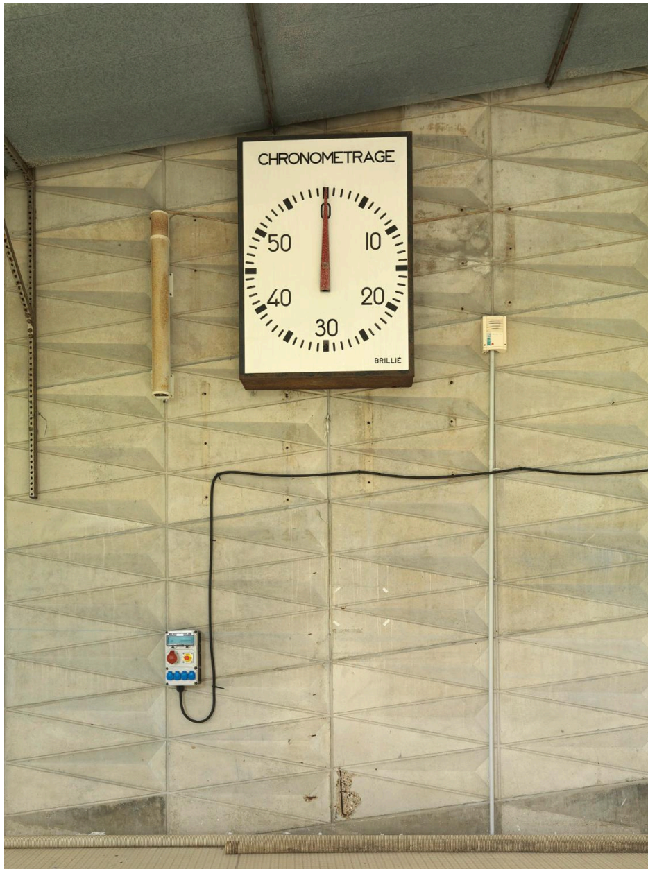
L'horloge de la piscine et les effets de coffrage du béton sur les murs.
