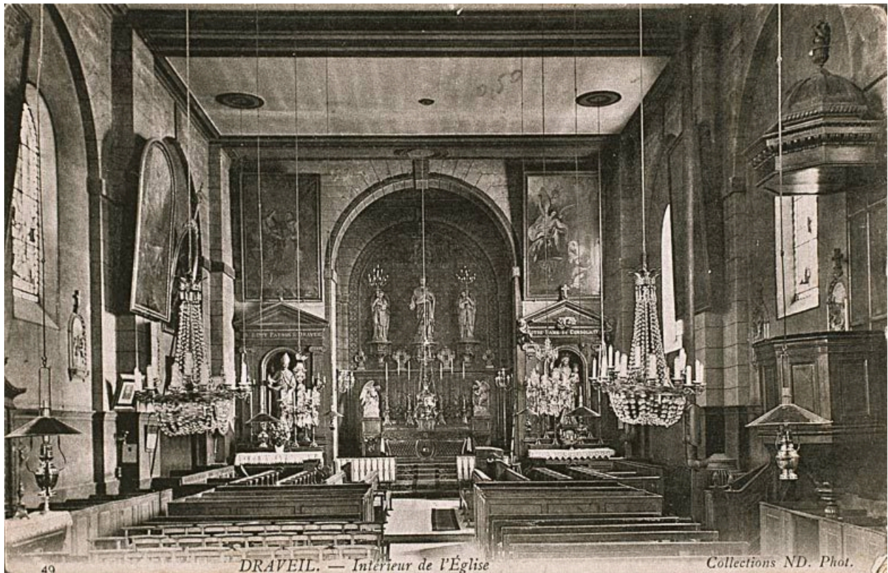
Vue de la nef en direction du choeur. Carte postale, vers 1910. (AD Essonne, 2 Fi 63)
