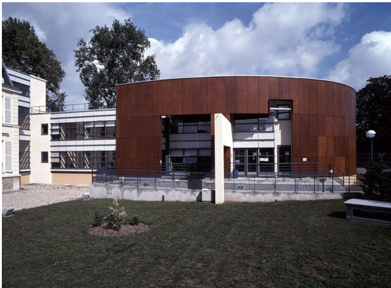
Bâtiment de la Maison des Solidarités, construite par le conseil général de l'Essonne en 2002-2003.
