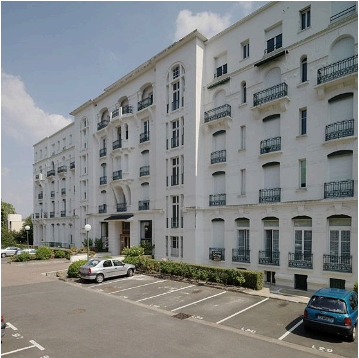
Façade nord de l'hôtel Savoy.
