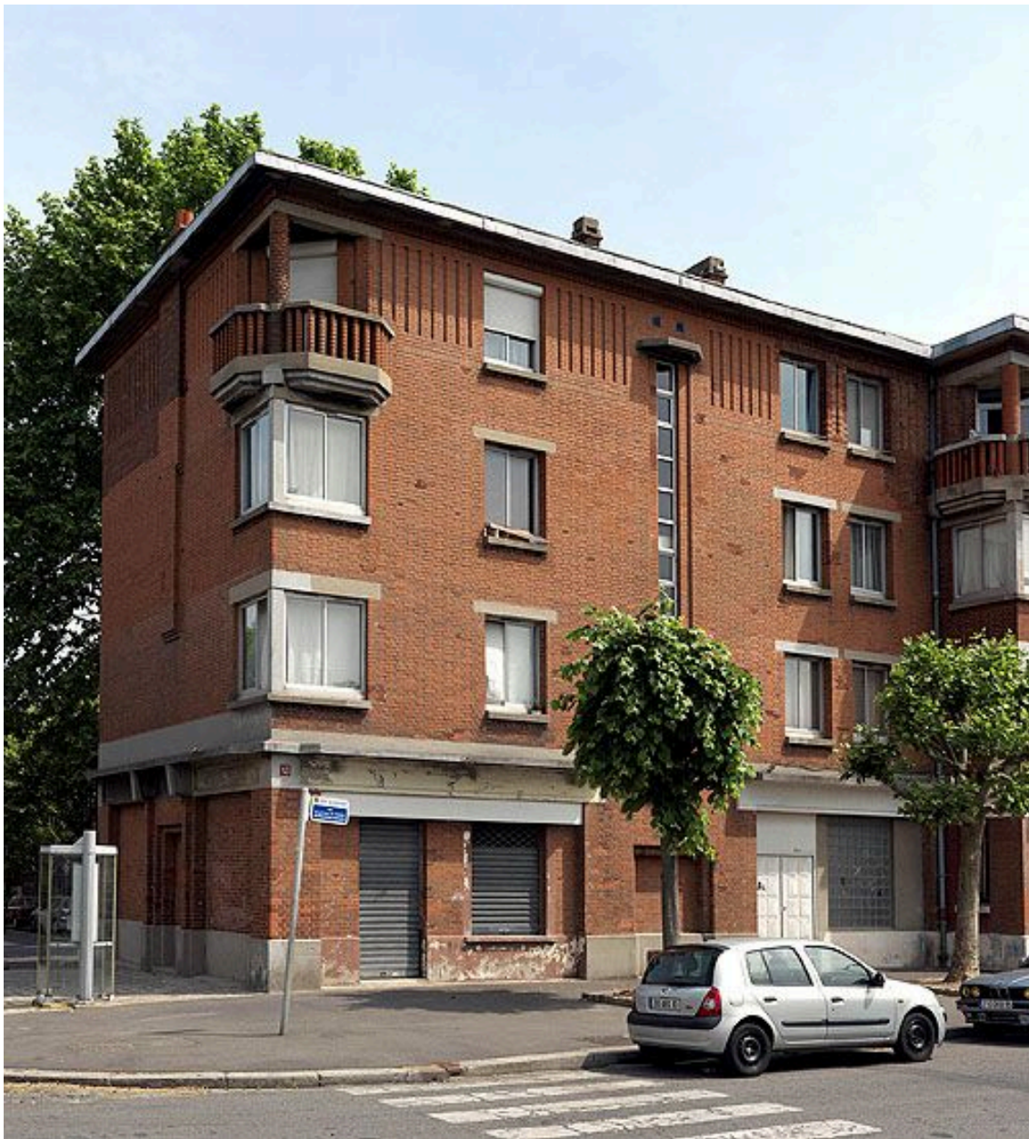
93, Dugny, cité l'Esquillez, rue Normandie-Niemen . Vue d'une aile de logements.
