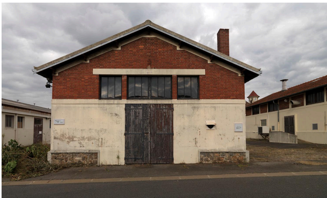
Site Biocitech. Vue des écuries désaffectées.
