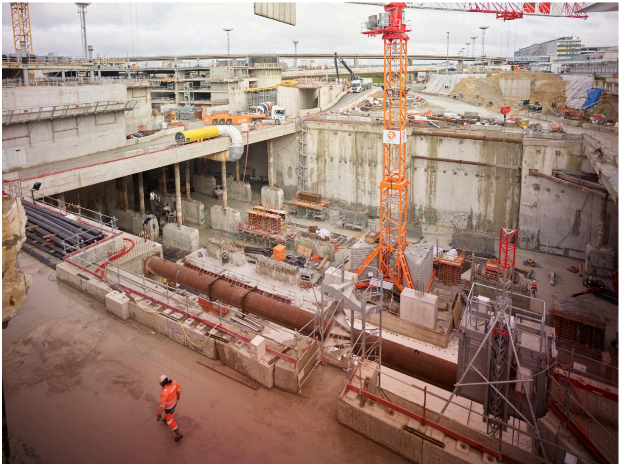
16/12/2020, chantier de construction de la station de métro Aéroport d'Orly (lignes 14 et 18) vu depuis l'ouest.
