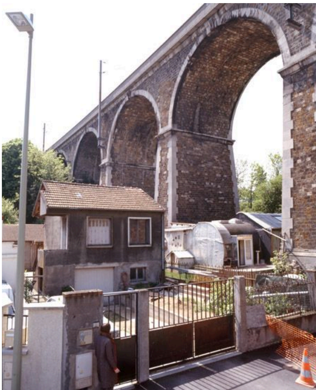
Viaduc de Nogent, quai Lucie. Bicoques au pied du viaduc de Nogent.
