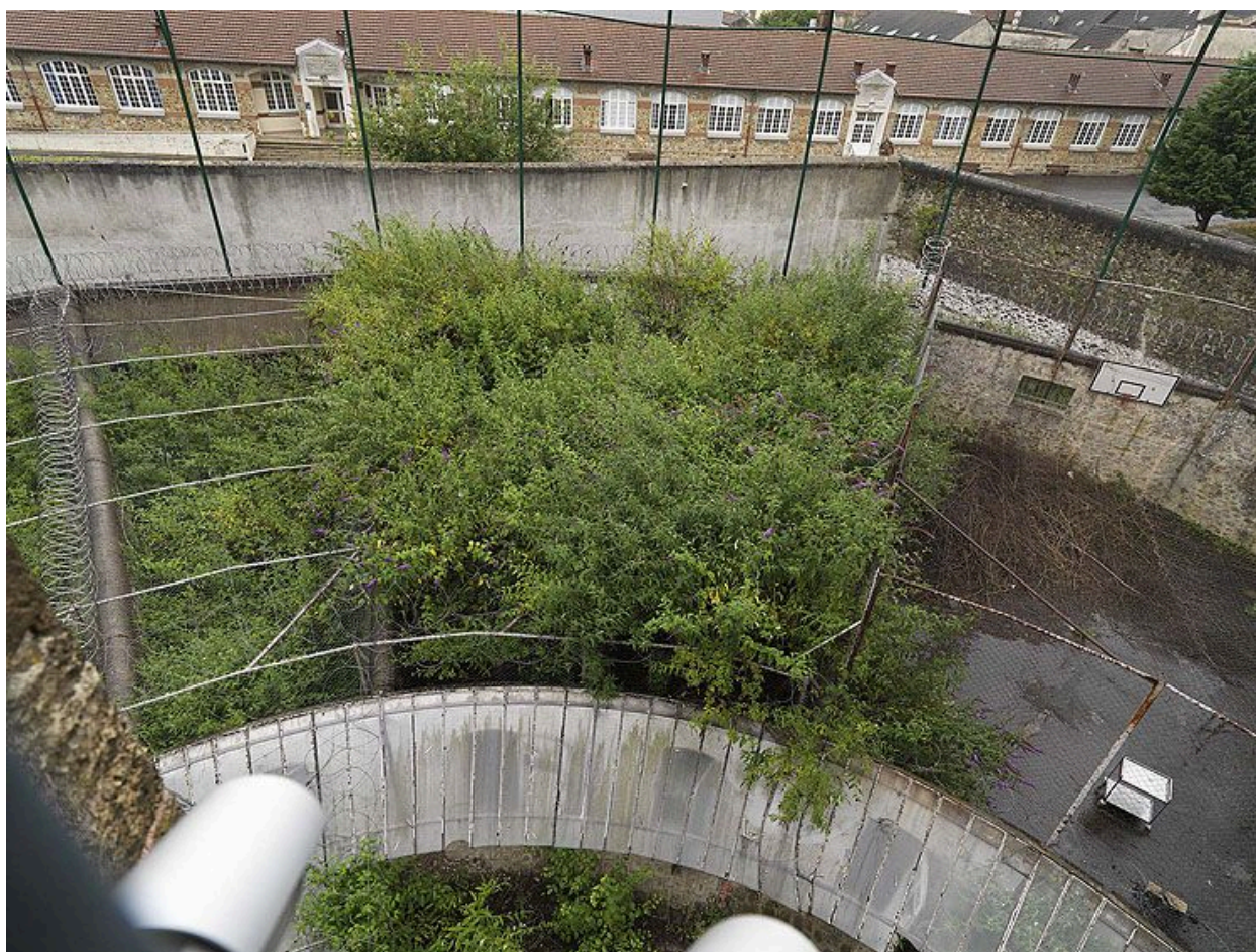
Les cours de promenade, vues depuis le haut (côté sud-est).
