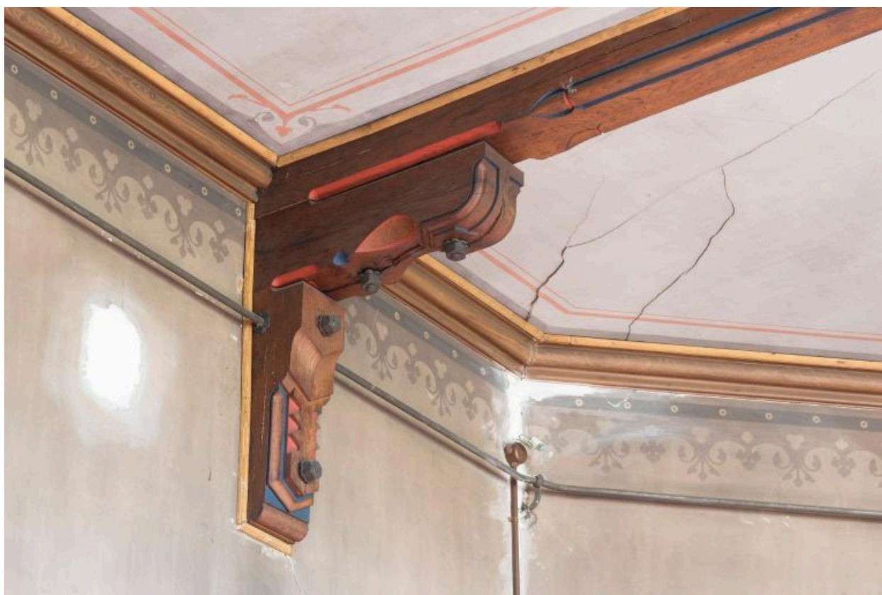
Poutre du plafond (1)
