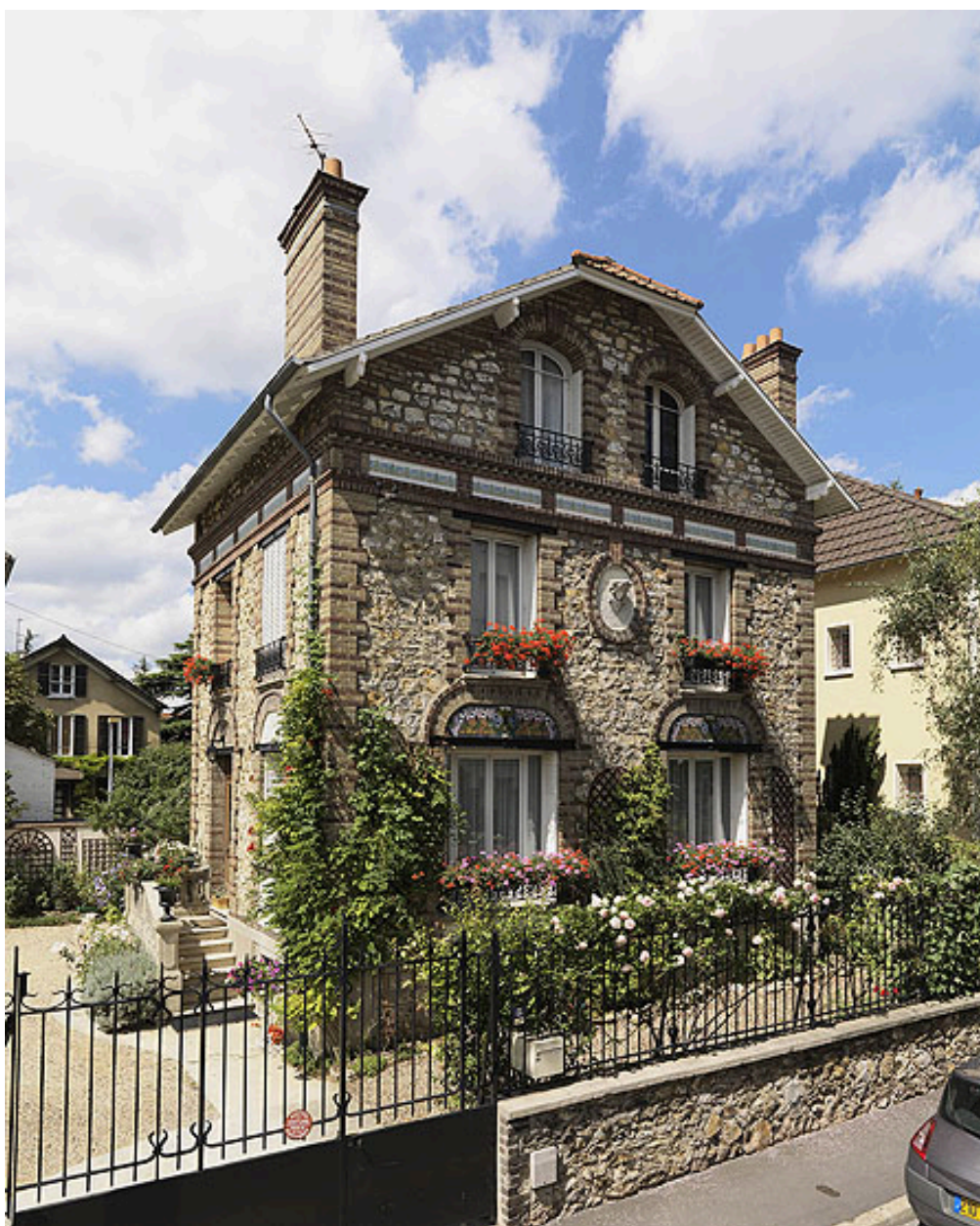
Vue d'ensemble de la façade antérieure.
