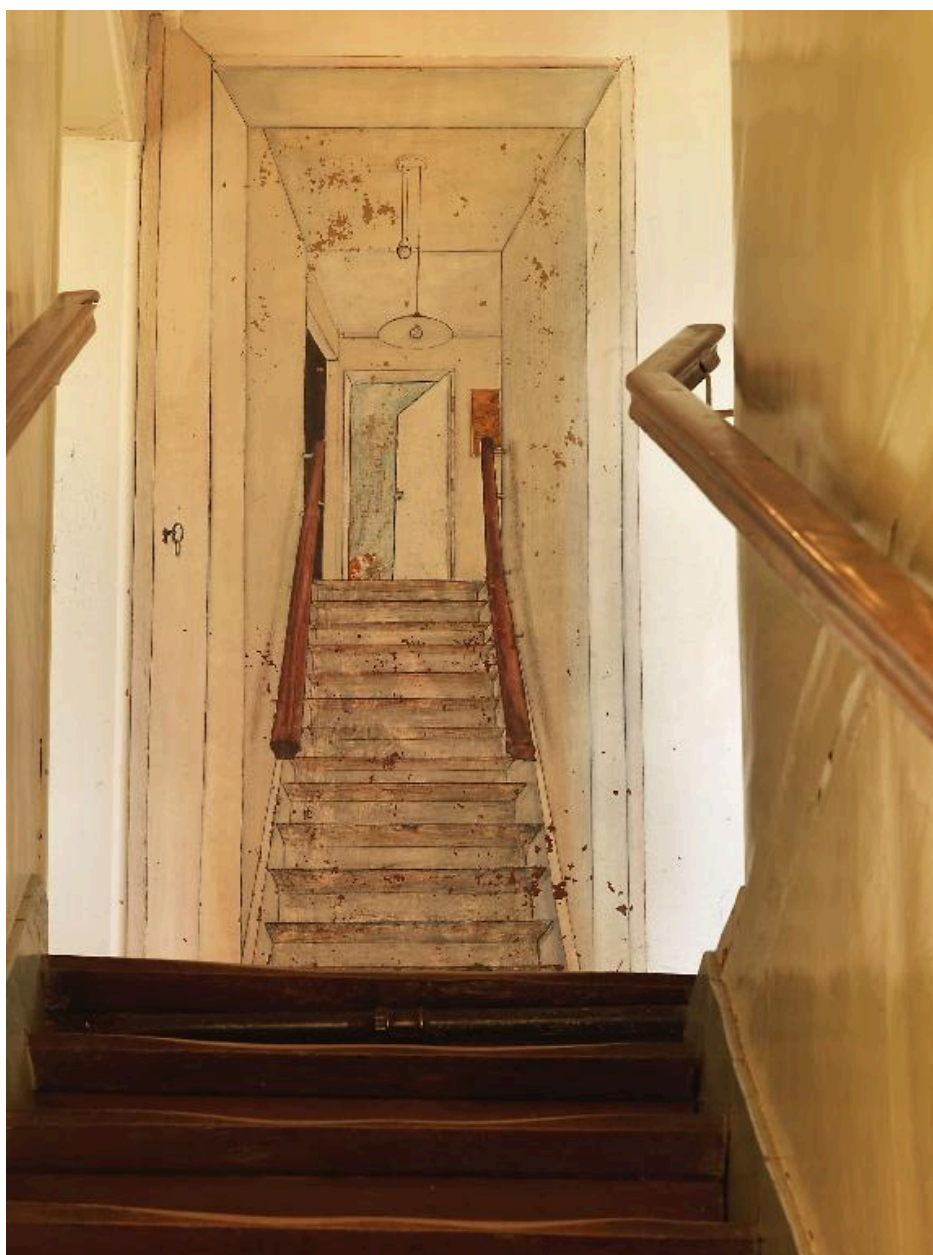
Escalier : trompe-l'oeil peint sur le mur du palier du premier étage (2)
