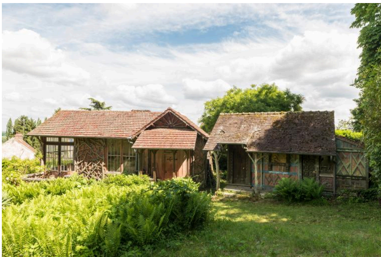
Vue générale des ateliers (2)
