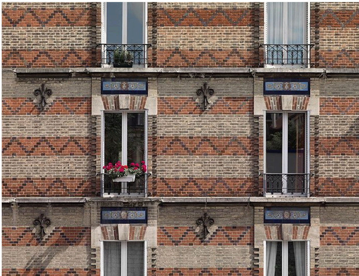
92, Suresnes, immeuble, 49 boulevard Henri-Sellier. Détail de l'appareil de brique polychrome de la façade antérieure.
