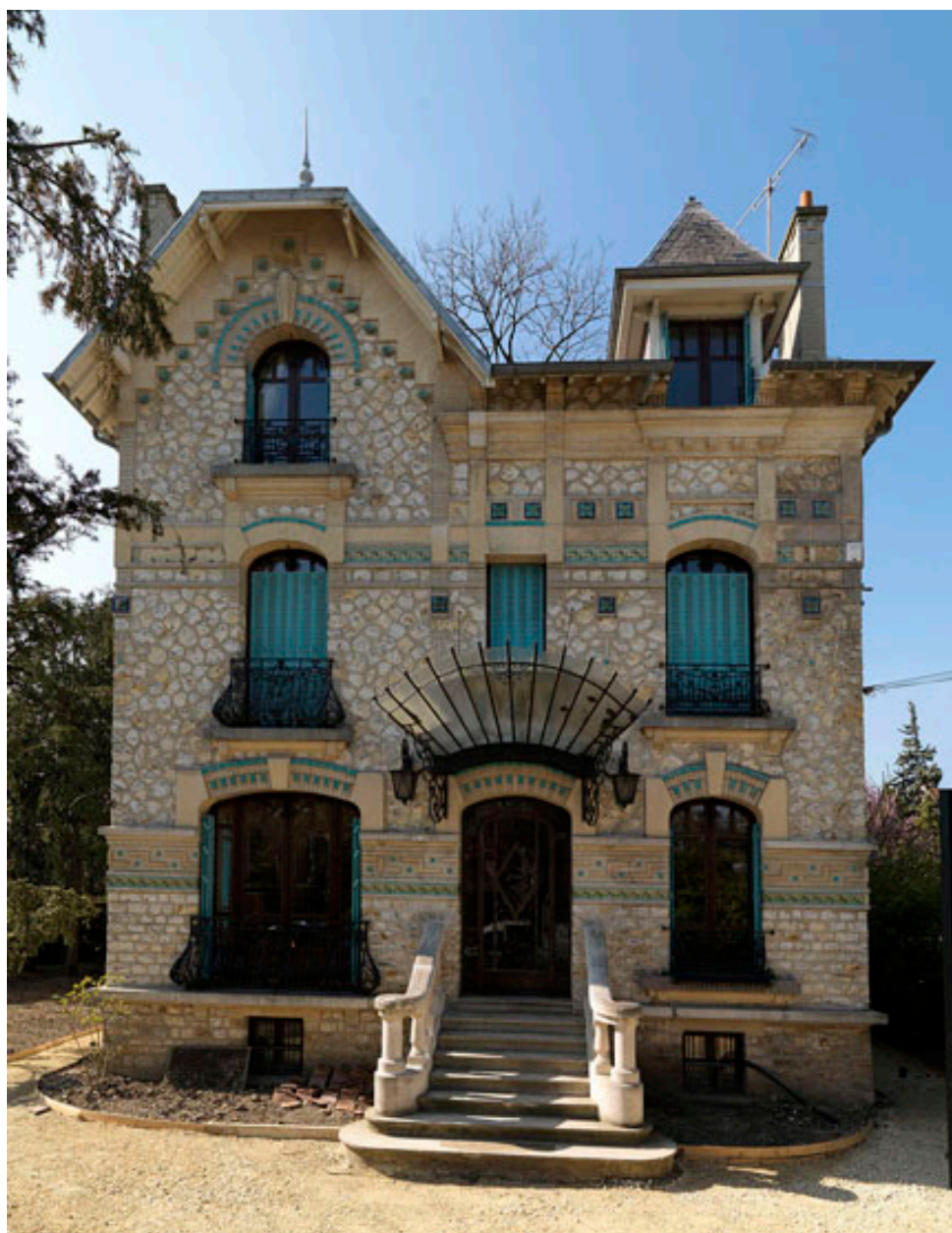
Vue d'ensemble de la façade antérieure ; maison construite par l'architecte Henri Moreels en 1927.
