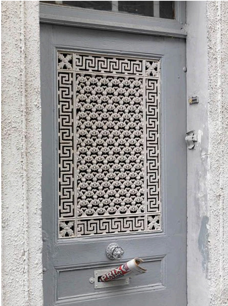
Maison de faubourg au 19, rue de Chaage : détail de la grille en fonte ornant la porte d'entrée.
