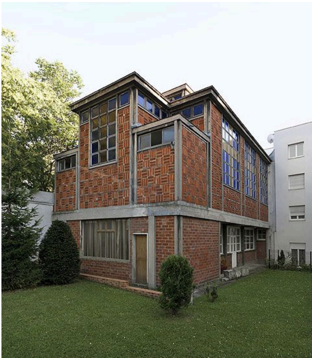
94, Arcueil, couvent de franciscaines, 37 avenue Lénine. Elévation et appareil du chevet de la chapelle.
