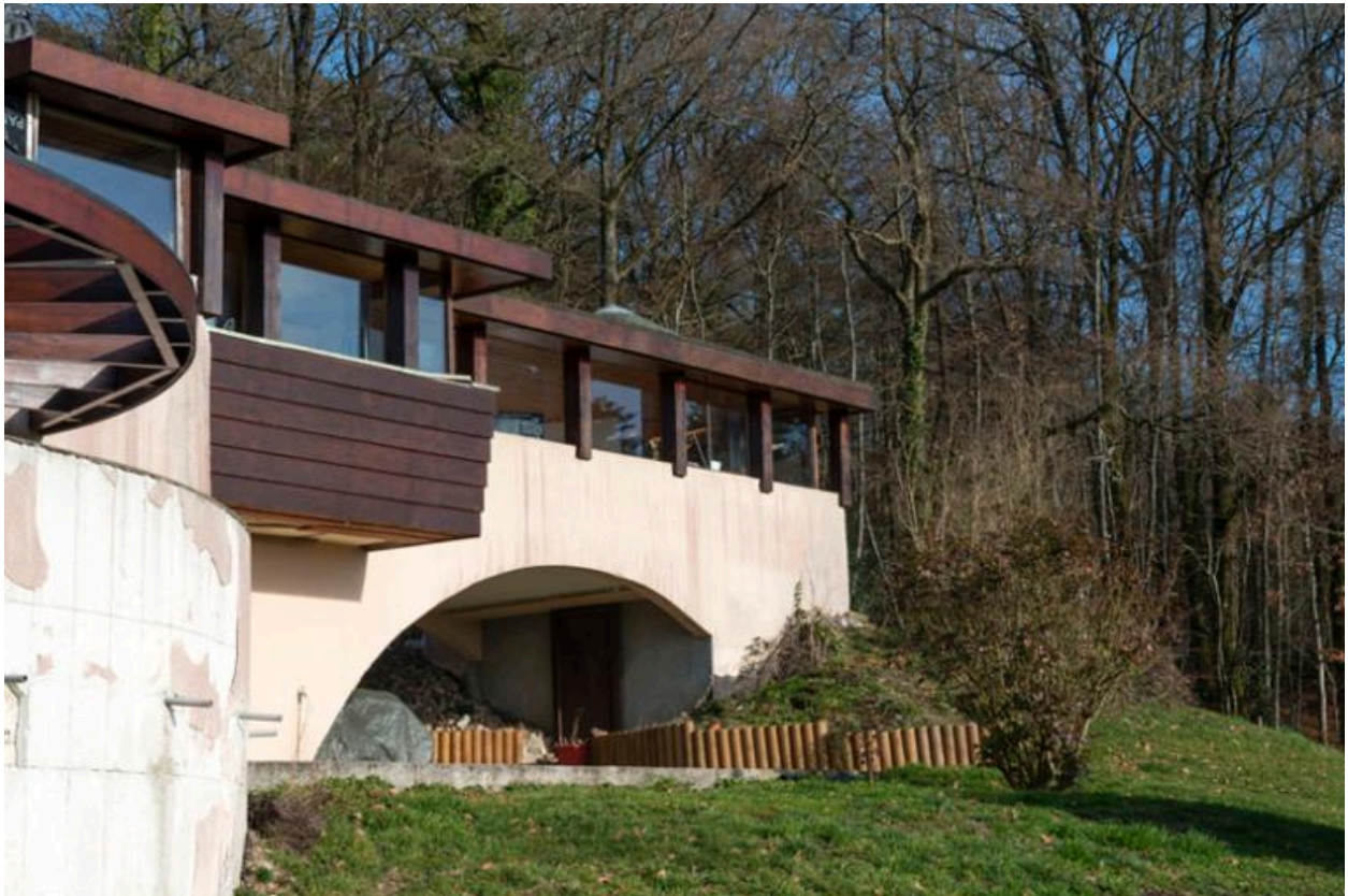
Vue de l'arche de soutènement.
