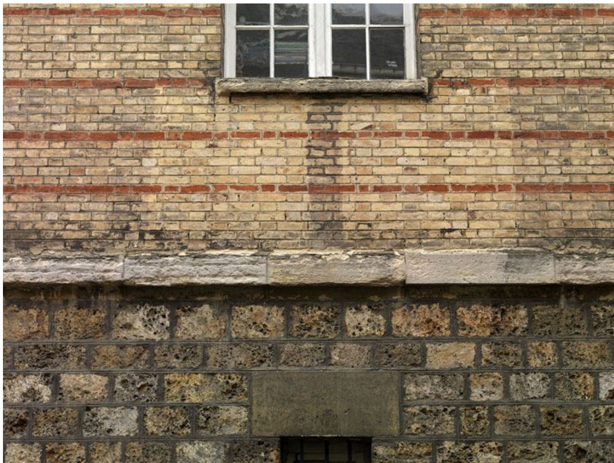
92, Sceaux, lycée Lakanal, 3-7 avenue du Président-Franklin-Roosevelt. Cour des cuisines : soubassement du bâtiment de service des cuisines.
