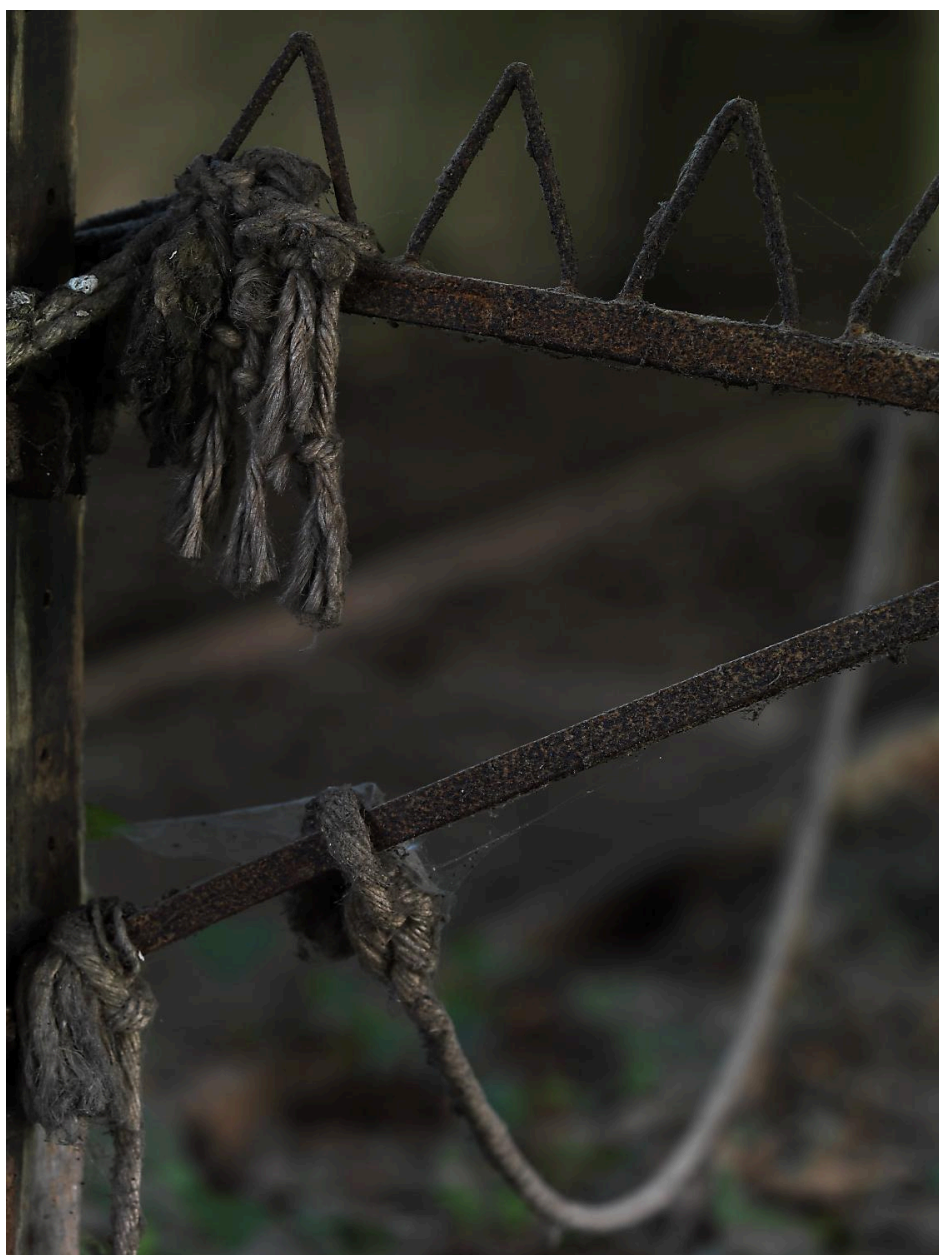
Installations pour le câblage des cordes, séparateur de torons.
