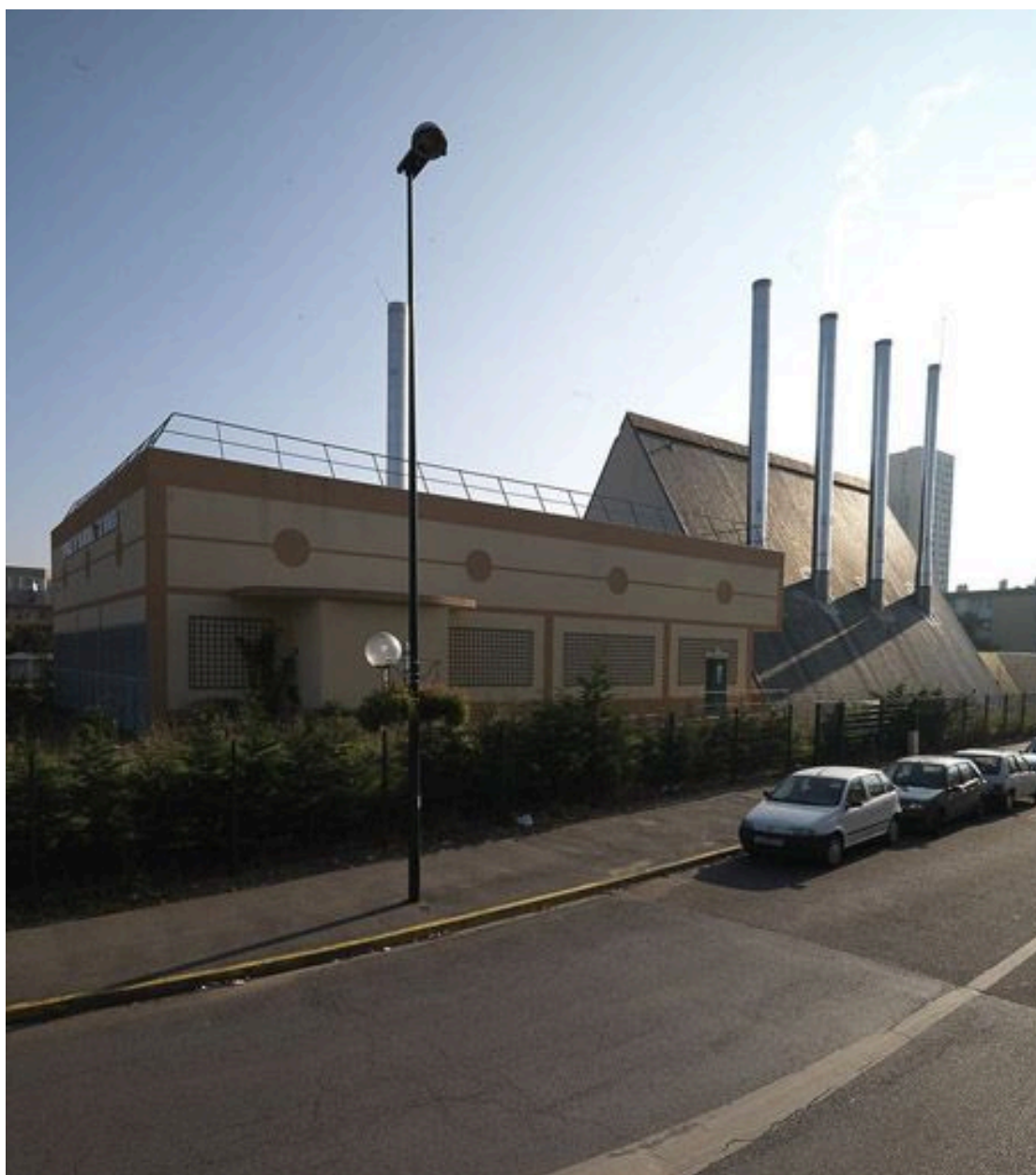
Vue d'ensemble de la chaufferie du grand ensemble, située au début de l'avenue de la Concorde, près de la gare.
