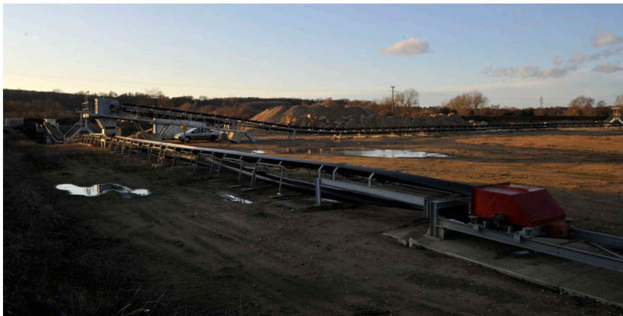
Triel-sur-Seine, carrière (sablère et gravière) Lafarge Granulats, 2 chemin des Graviers. Bandes transporteuses.
