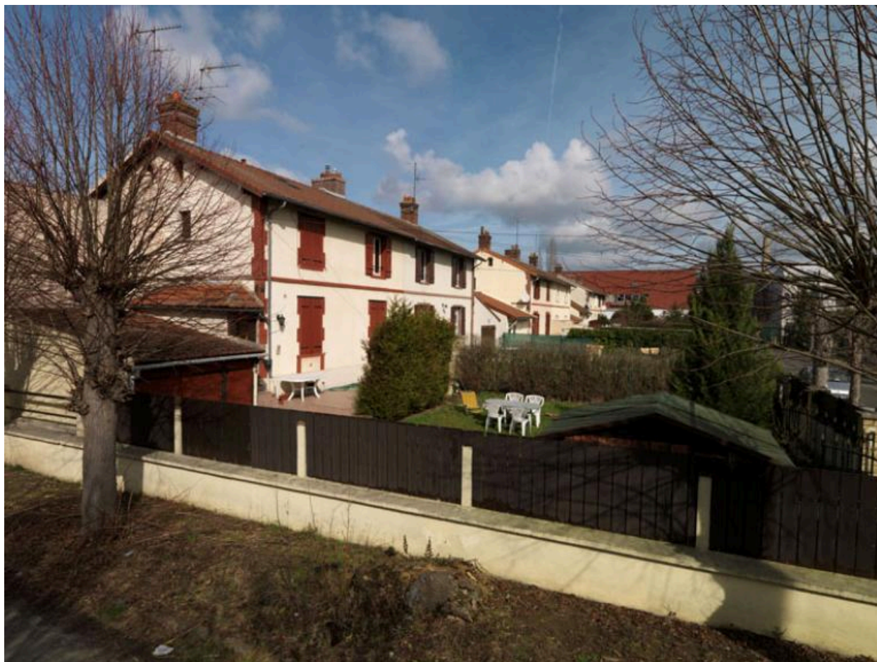
la Cité Braunstein : alignement de maisons doubles.
