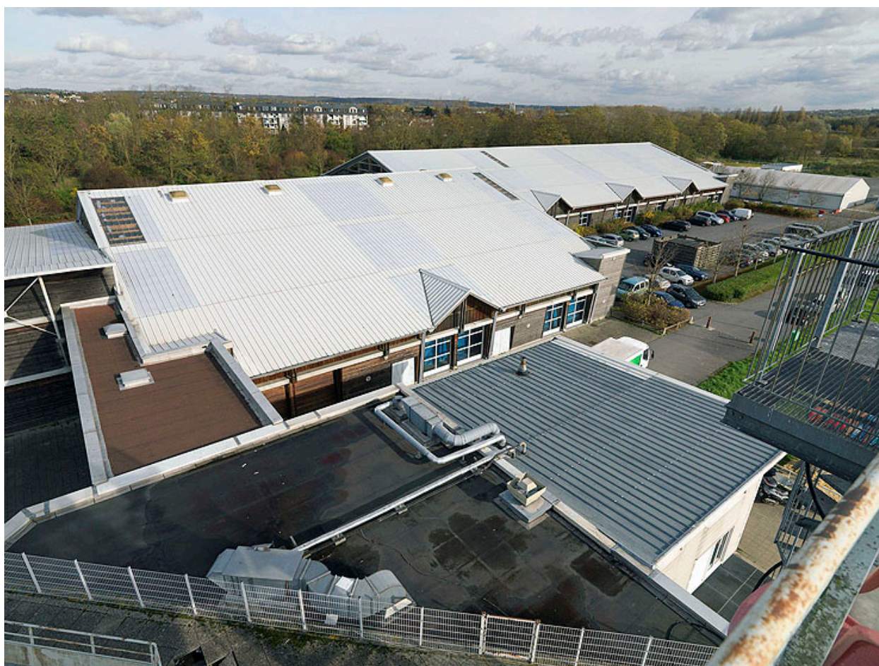
Les gymnases au nord-est du lac de Vaires, vue panoramique prise depuis la tour d'arrivée.
