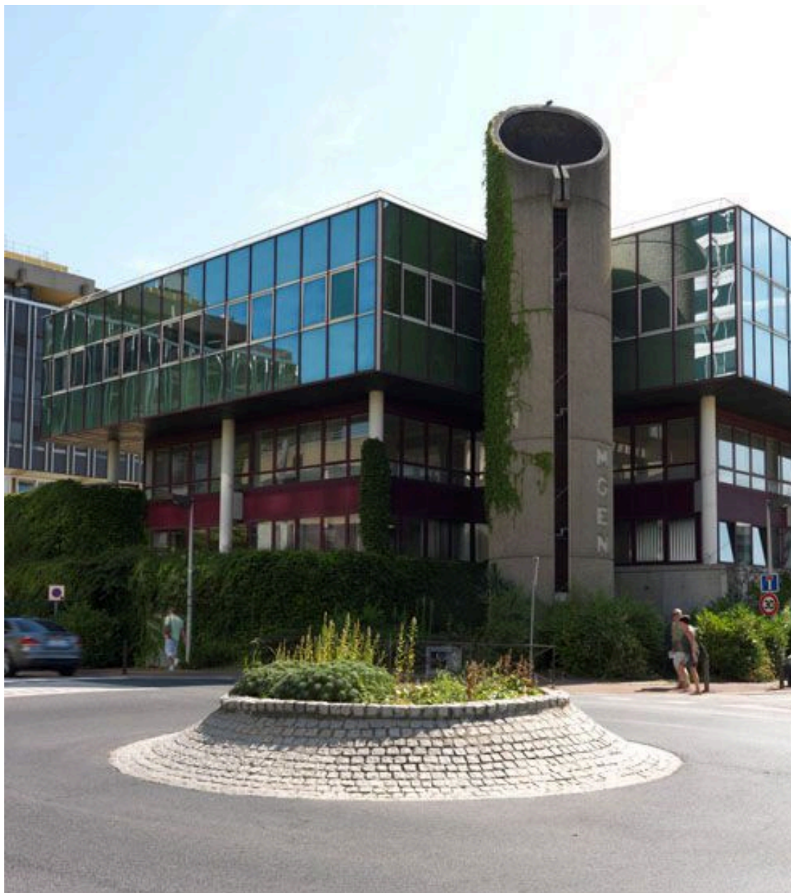
Vue du bâtiment MGEN situé à l'angle de la rue du Verger et de l'avenue de la Poste.
